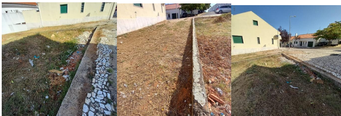
Fig. 5, 6 e 7 - Murete existente em alvenaria de blocos de betão a recuperar a capear com lajetas de mármore branco da região.
