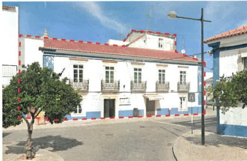
ALÇADO PRINCIPAL | Foto da Rua Fernão Penteado (agosto 2020)
