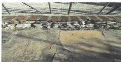
Fig. 12 –Murete existente em alvenaria de pedra arrumada à mão capeado com 4jolo burro a recuperar com a remoção da rede de vedação.
