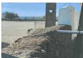
Fig. 17 e 18 – Muro existente em alvenaria de pedra arrumada a mão capeada com cimento de diversas idades e colorações
