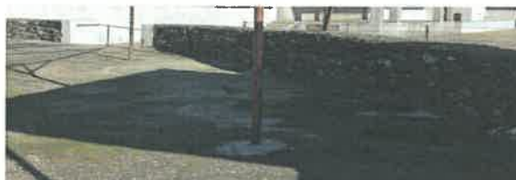
Fig. 17 e 18 – Muro existente em alvenaria de pedra arrumada a mão capeada com cimento de diversas idades e colorações
