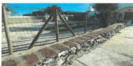
Fig. 12 –Murete existente em alvenaria de pedra arrumada à mão capeado com 4jolo burro a recuperar com a remoção da rede de vedação.
