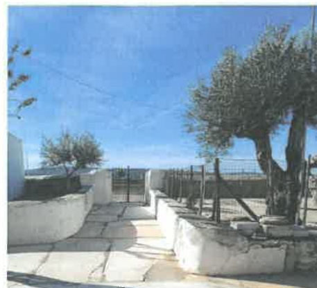
Fig. 15e 16—Muro existente em alvenaria de pedra a mão, rebocado e caiado no exterior, e in
