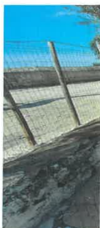
Fig. 13 e 14 - Murete existente em alvenaria de pedra arrumada à mão capeado com betão e lajetas de mármore a recuperar com capeamento arredondado, rebocado e pintado de branco.
