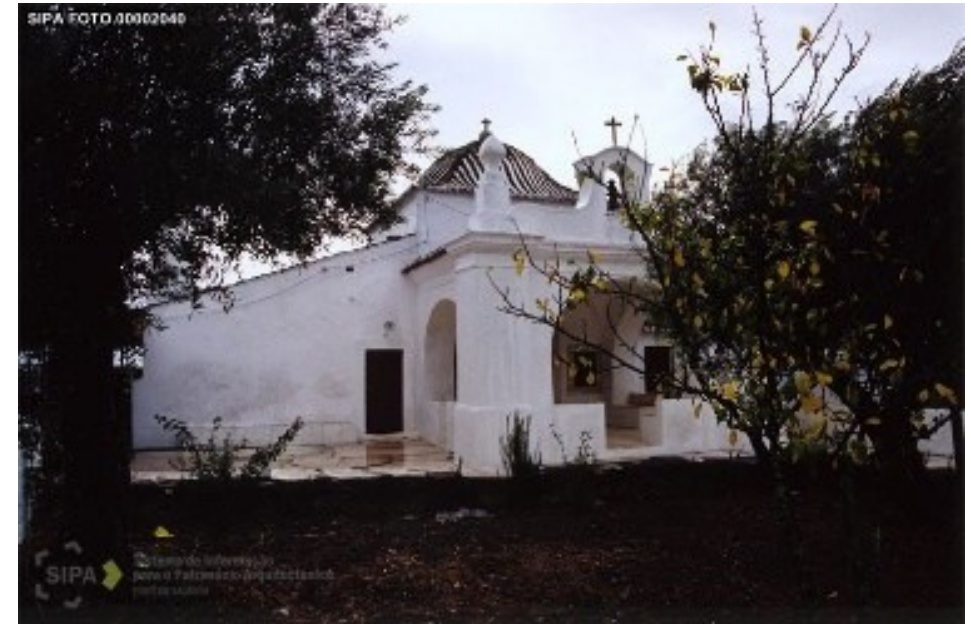
3.1.5.28. – Ermida de Nossa Senhora da Vitória / Ermida de Santa Vitória de Montes Claros
