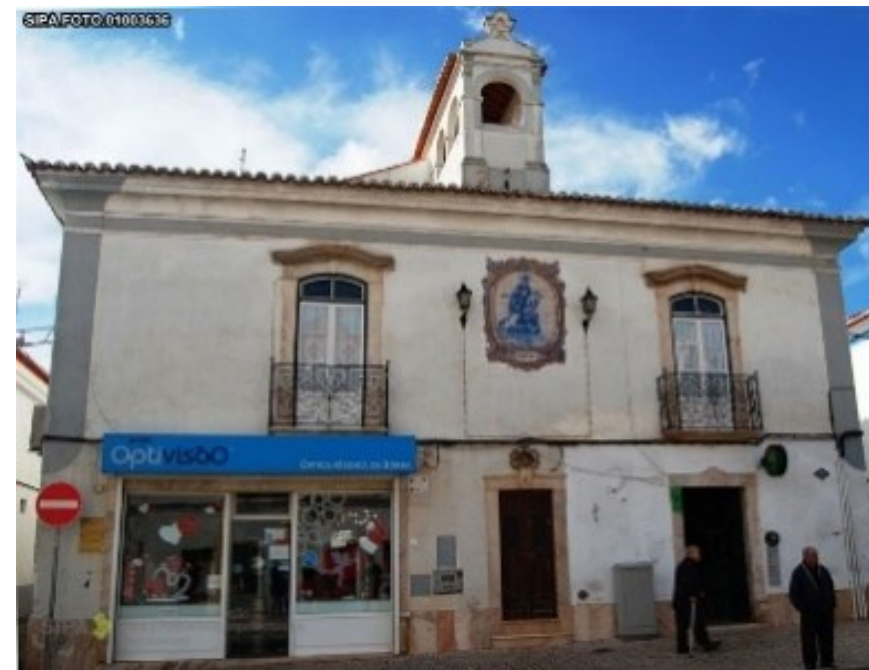
3.1.5.13. - Casa na Rua Humberto Silveira Fernandes, n.º 8 a 12
