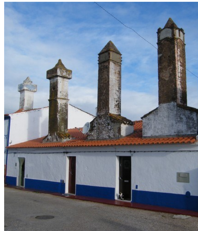
3.1.5.43. – Chaminés da Aldeia de Sande
