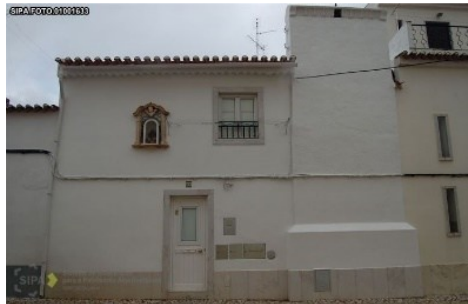
3.1.5.6. -Casa na Rua de São Francisco, n.º 28
