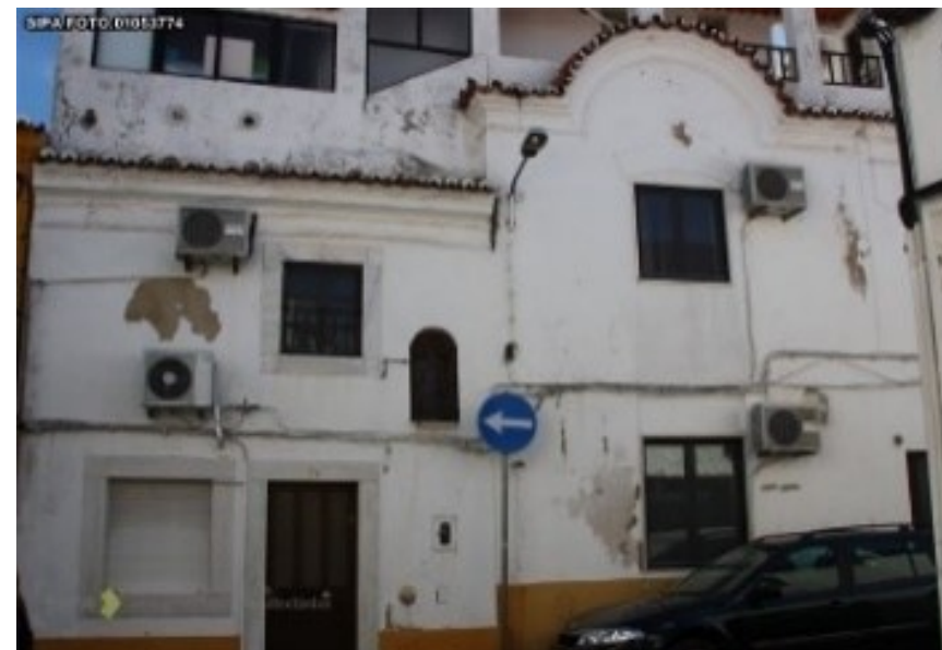
3.1.5.9. - Casa na Rua de Visconde de Gião, n.º 9 a 13
